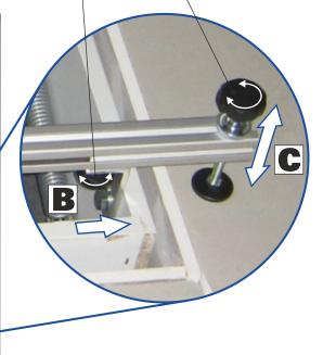
Futterkasten ausrichten und befestigen (Einbauhinweis Bodentreppen)
